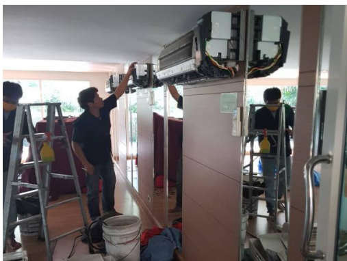
ล้างทำความสะอาดเครื่องปรับอากาศ ภาพที่ 2.2-7 (ต่อ) ระบบไฟฟ้าและการอนุรักษ์พลังงาน
