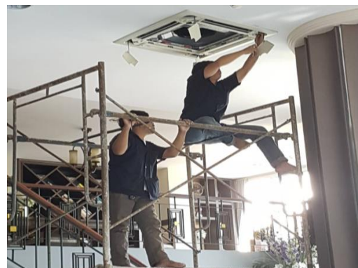
ล้างทำความสะอาดเครื่องปรับอากาศ ภาพที่ 2.2-7 (ต่อ) ระบบไฟฟ้าและการอนุรักษ์พลังงาน
